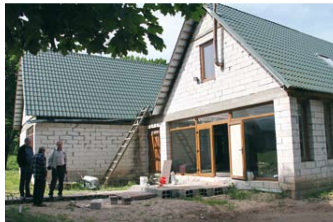
▲ Päärakennuksen ulkopinnoitus ja alle lämpöeriste.
