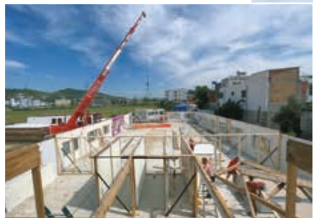
▲ Uusi rakennus nousee vauhdilla.
